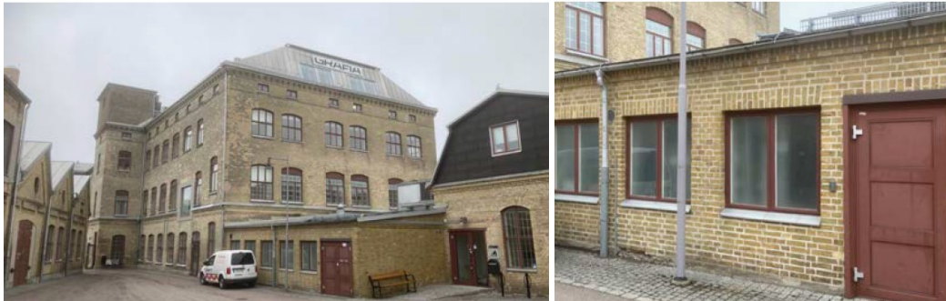
Nya väverikontoret mellan väveri och portvaktshus, fasad mot väster (WSP)
