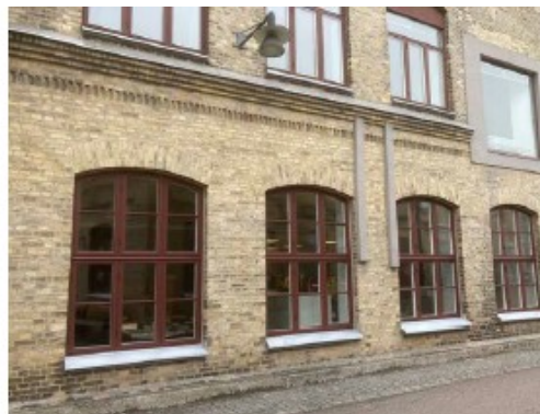
Väveriet med tillbyggnad mot norr (t.v.) samt fönster med segmentbågar och solbänkar i sandsten (WSP)
