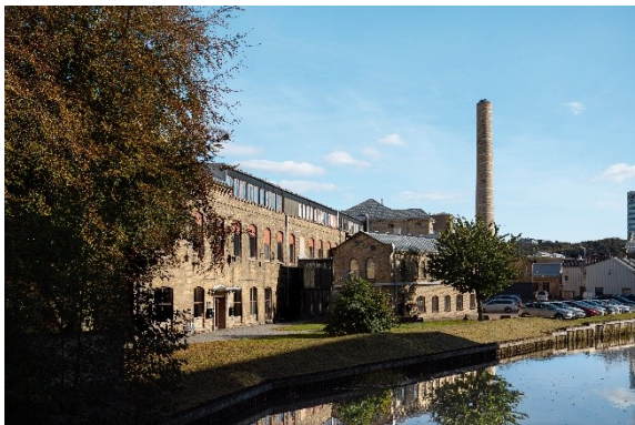
Miljöerna vid Mölndalsån var tidigare tätbebyggda med fabriksbyggnader. Skorstenen markerar området på långt håll. (Liljewall)
