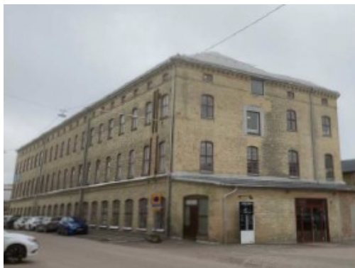
Väveriet med tillbyggnad mot norr (t.v.) samt fönster med segmentbågar och solbänkar i sandsten (WSP)
