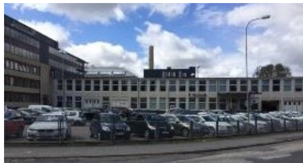
Gamla syfabriken sedd från korsningen Almedalsvägen-Skårs Led. Till vänster i bild skimtar en kontorsbyggnad uppförd på 60-talet. (SBF)
