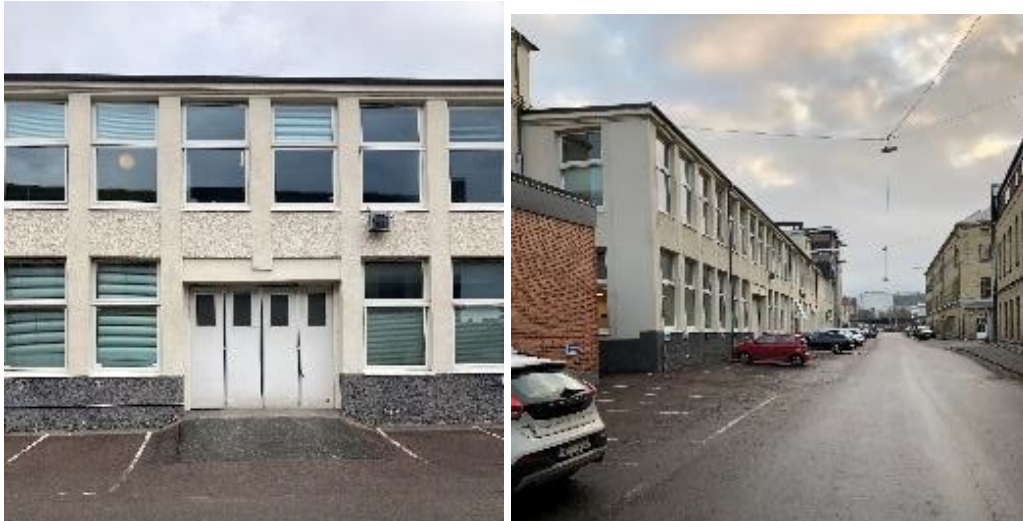
Syfabriken (Stadsbyggnadsförvaltningen, Liljewall)
