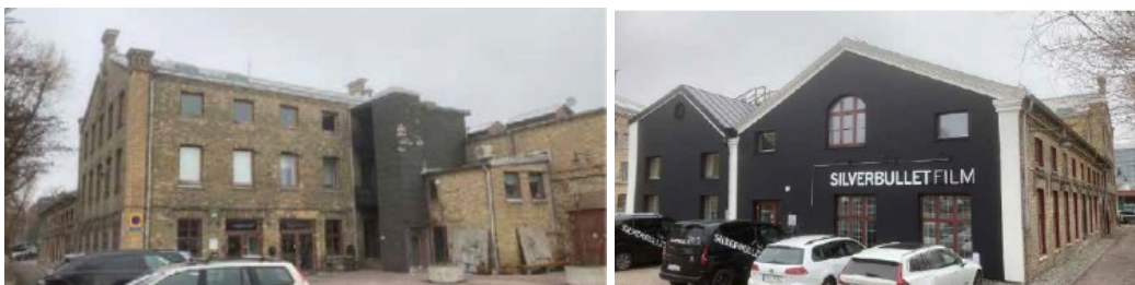
Färgeriet, sett från söder och norr (WSP)
